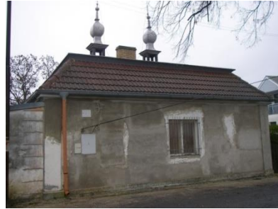
Domeček v průběhu rekonstrukce
