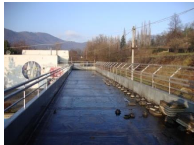
Oprava střechy nad kabinkami
