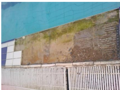
Oprava přelivných hran
