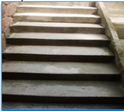
Oprava schodů WC Klášterní
