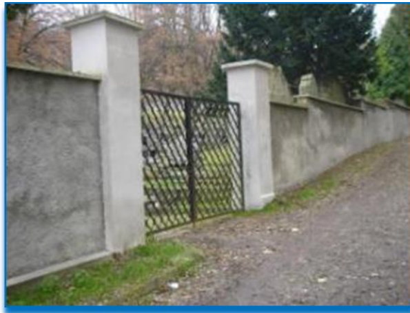
Opravená obvodová zeď Krásné Březno
