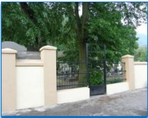
Opravená obvodová zeď Vaňov
